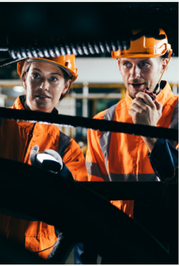
Ingénieurs effectuant des travaux de maintenance sur la voie ferrée Photo : AdobeStock
