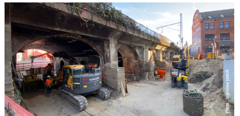
Fouilles pour les fondations du pont provisoire, 20 février 2025
