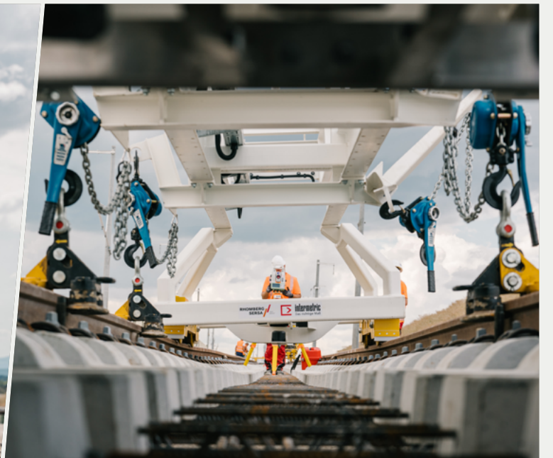
Unterstützung beim Bau Fester Fahrbahnen
